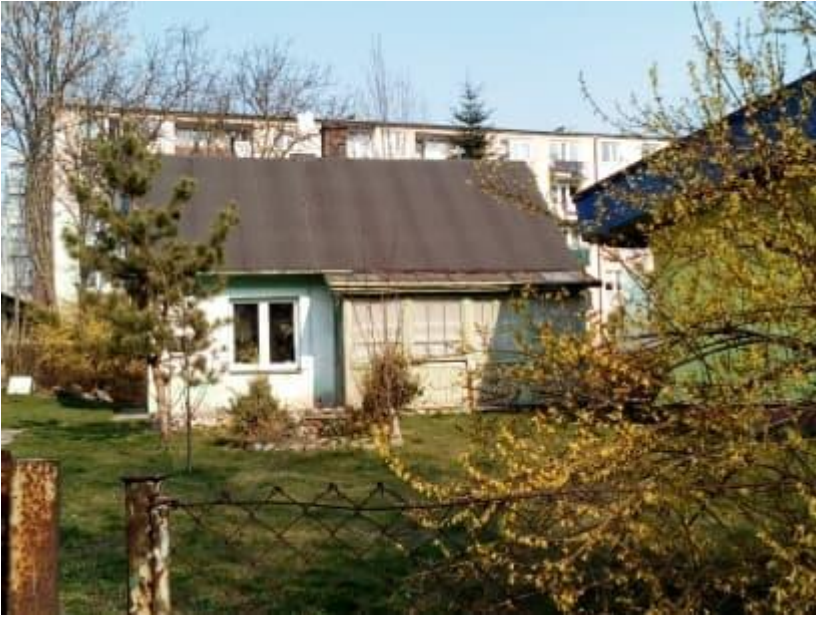
Budynek ZGK Szczepieszyn Sp. z o. o. przy ul. Zamojskiej 19:
